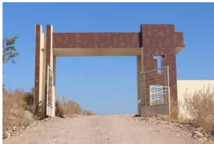
Construcción del nuevo Panteón Municipal.
