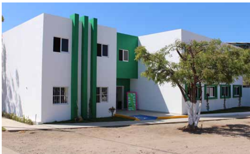
Construcción del Centro de Desarrollo Comunitario.
