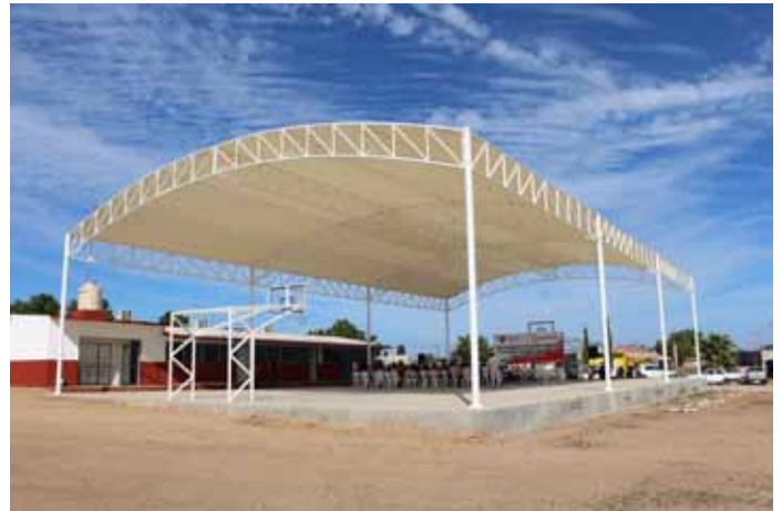
Construcción de techumbre en la escuela primaria "Nueva Creación", en La Cruz.
