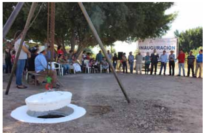
Sistema de alcantarillado y saneamiento para la comunidad de Las Tinajas.
