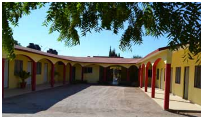
Logramos la construcción de la segunda etapa de la Casa del Abuelo.
