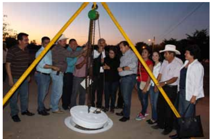
Inauguración del sistema de alcantarillado y saneamiento en la comunidad de Tayoltita.
