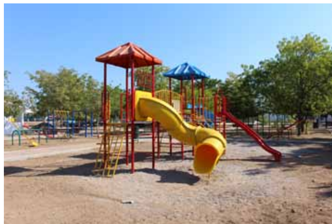
Construcción del Parque Infantil "La Cruz" en la Unidad Deportiva "Julio Lerma Quintero".
