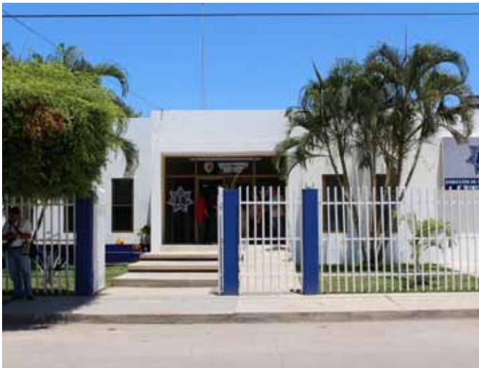
Nuevo edificio de la Dirección de Seguridad Pública y Tránsito Municipal (DSPyTM).
