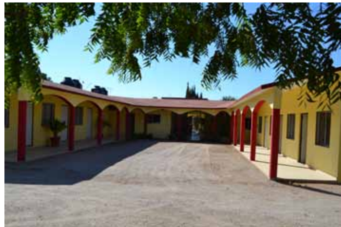
Construcción de la segunda etapa de la Casa del Abuelo.
