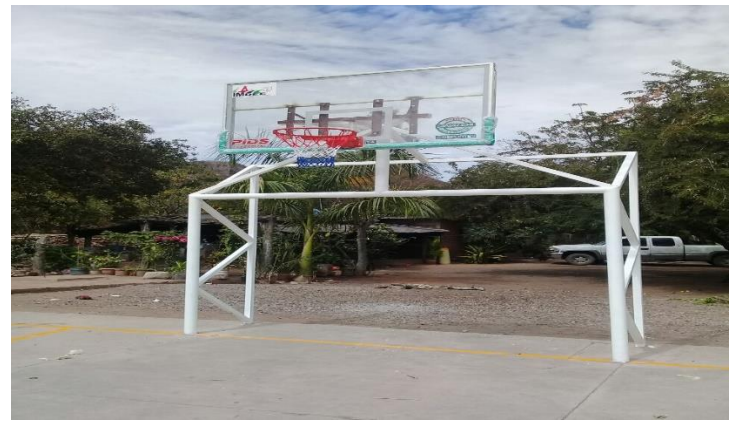
COLOCACION DE TABLEROS DE BASKETBOL
