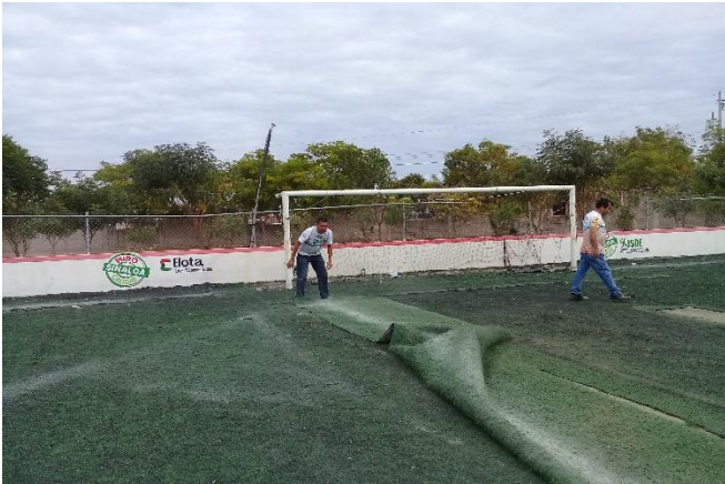
REPARACION DE CESPED SINTETICO DE LA CANCHA DE FUTBOL 7 DE LA UNIDAD DEPORTIVA.
