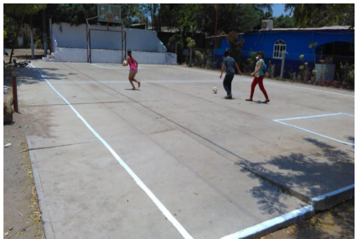
PINTA DE CANCHAS DE USOS MULTIPLES EN ESCUELAS
